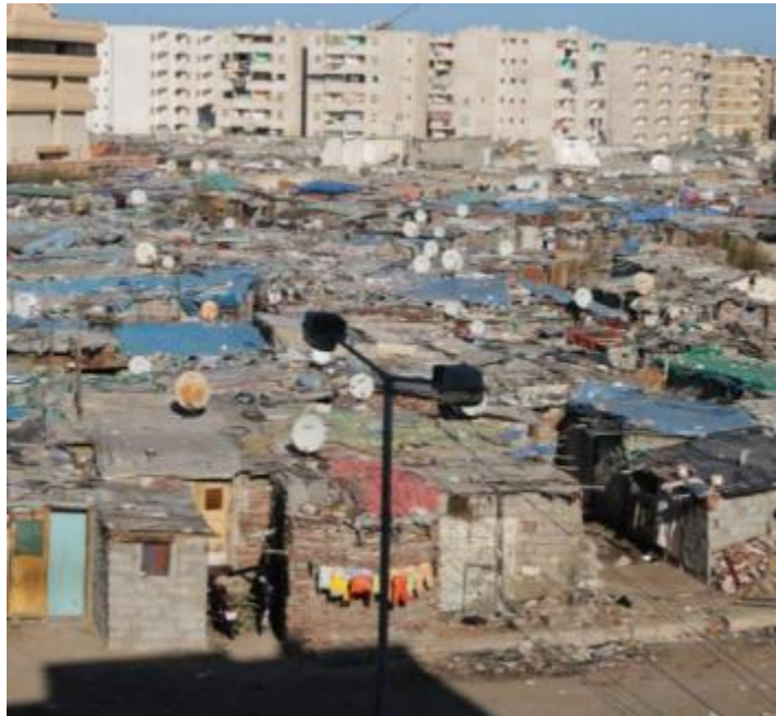
منطقة زرزارة - حي الضواحي - محافظة بورسعيد
